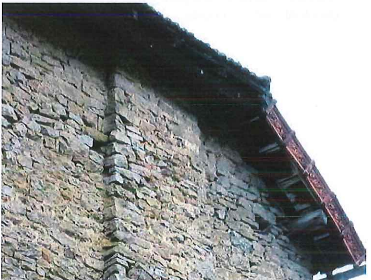
Les dessous de toit sont maintenus en bois naturel, non teinté, non peint.
