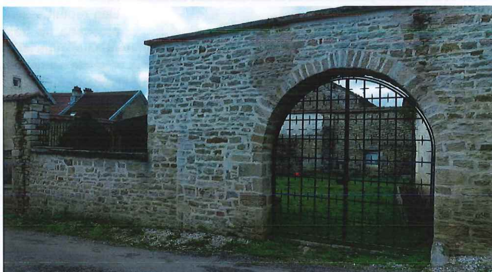
Au sein d'un haut mur en pierres qui marque l'alignement, la transparence de la grille ouvre la vue vers le jardin : une petite respiration verte.
