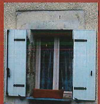
Lindeau daté servant de pierre de fondation
