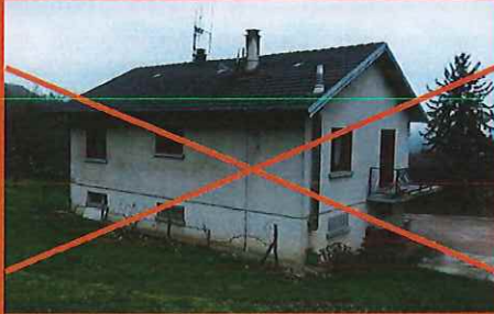
Les conduits en façade sont proscrits
