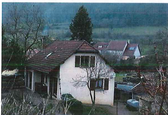
Le chauffage au bois reste un mode de chauffage bien représenté, y compris dans les nouvelles constructions.
