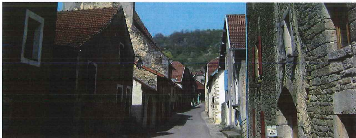
Le caniveau délimite un alignement régulier, mais les constructions, installées en limite parcellaire, s'implantent parfois en retrait, parfois au droit de ce caniveau.
