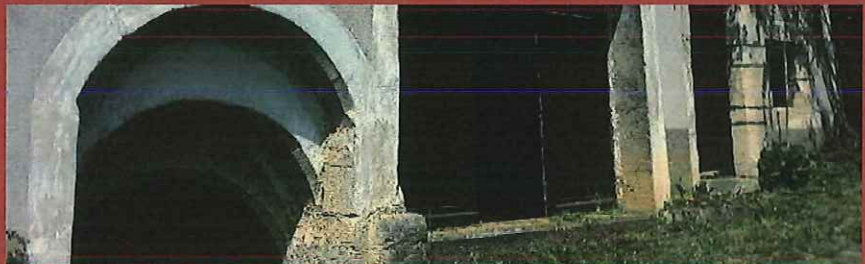
Pierres d'encadrement* décalées
