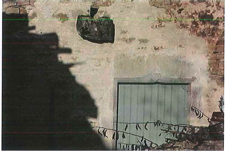
La réparation ponctuelle de l'enduit est préférée à la réparation complète de la façade : elle maintient le caractère ancien du mur.
