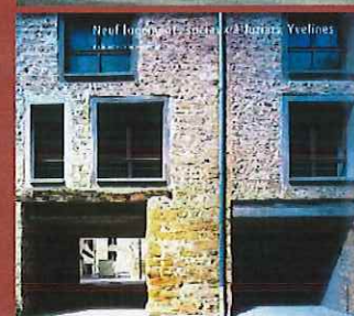
Les ouvertures réalisées sur ces constructions reprennent le découpage des baies traditionnelles du bâti ancien : portes piétonnes, portes de grange, etc...
